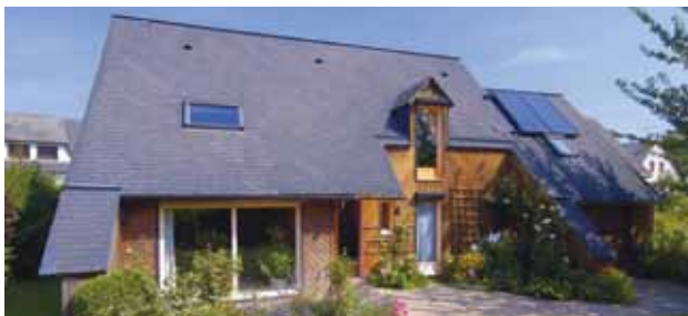
L'isolation du toit est essentielle car 25 à 30 % de la chaleur s'échappe par la toiture.
